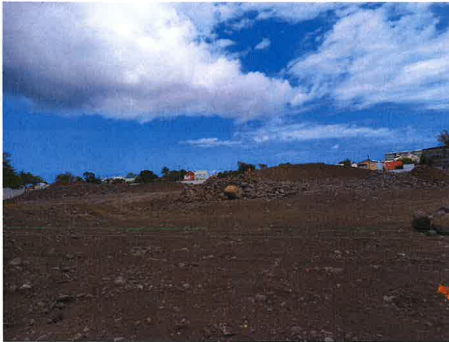
Figure 9: Zone 5 (le futur parc) - décembre 2022
