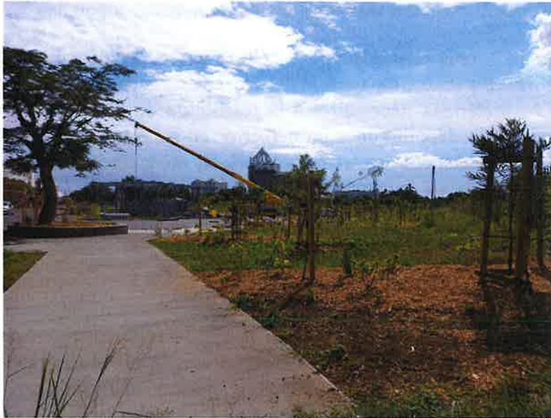
Figure 9 : Pôle Aimé Césaire en travaux-mars 2022
